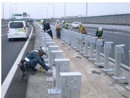
施工中イメージ
