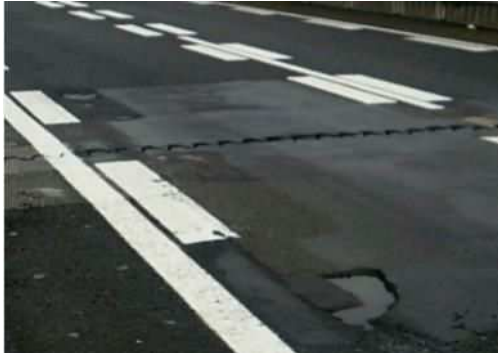
舗装の損傷状態イメージ
