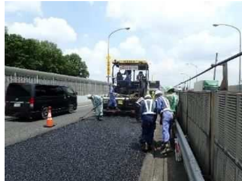
舗装工事イメージ
