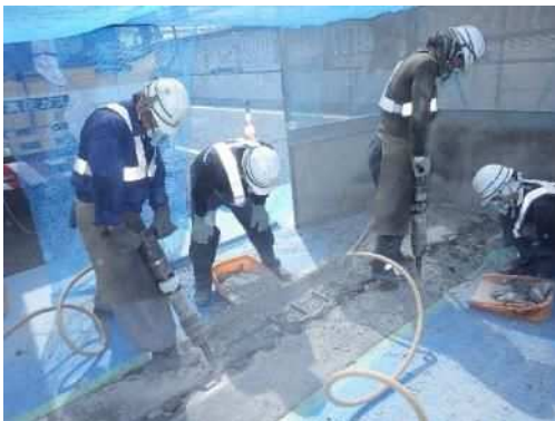
施工中イメージ
